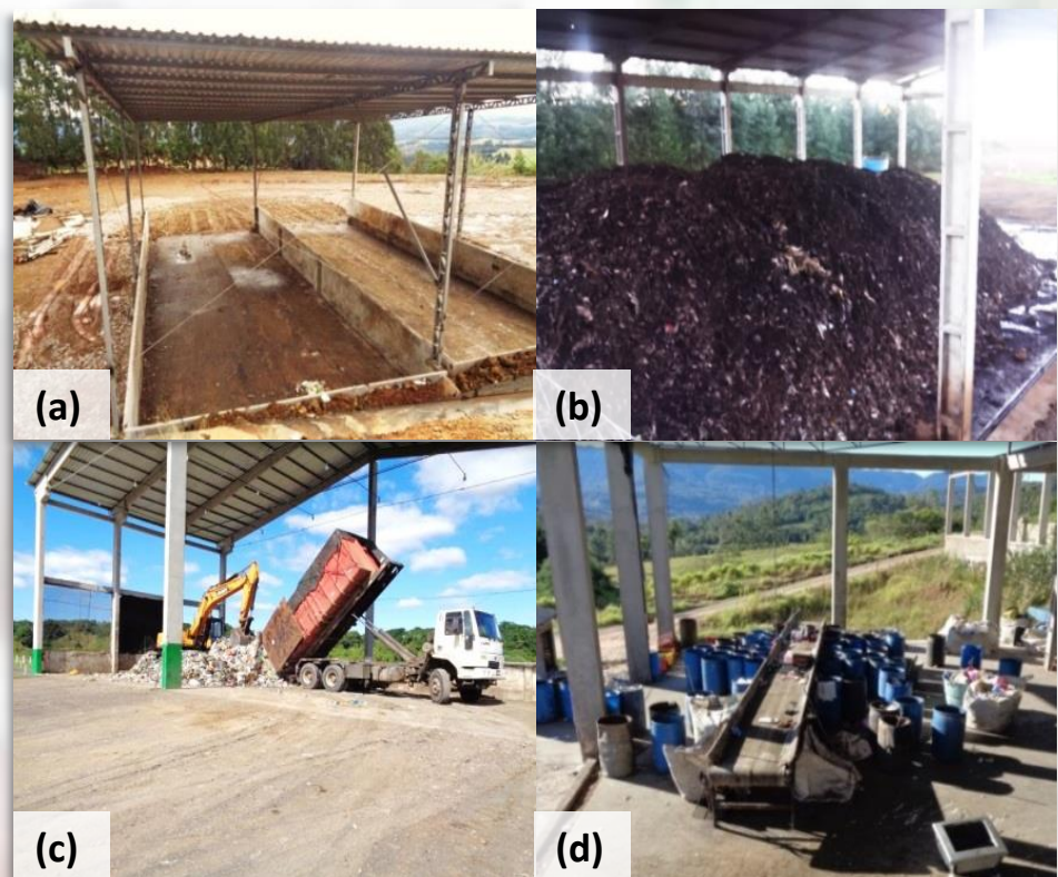
Fig. 2. Exemplos de empreendimentos associados aos RSUs licenciados no RS, Brasil. (a) Unidade de compostagem. (b) Leiras de compostagem. (c) Estação de transbordo. (d) Central de triagem. Fonte: Arquivos Fotográficos da DIRS/FEPAM.
