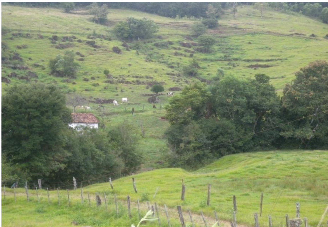
Foto 5-16 Colúvio em encosta íngreme com sinais de rastejo e trincas indicando ruptura do material superficial, Bacia do Médio Uruguai
