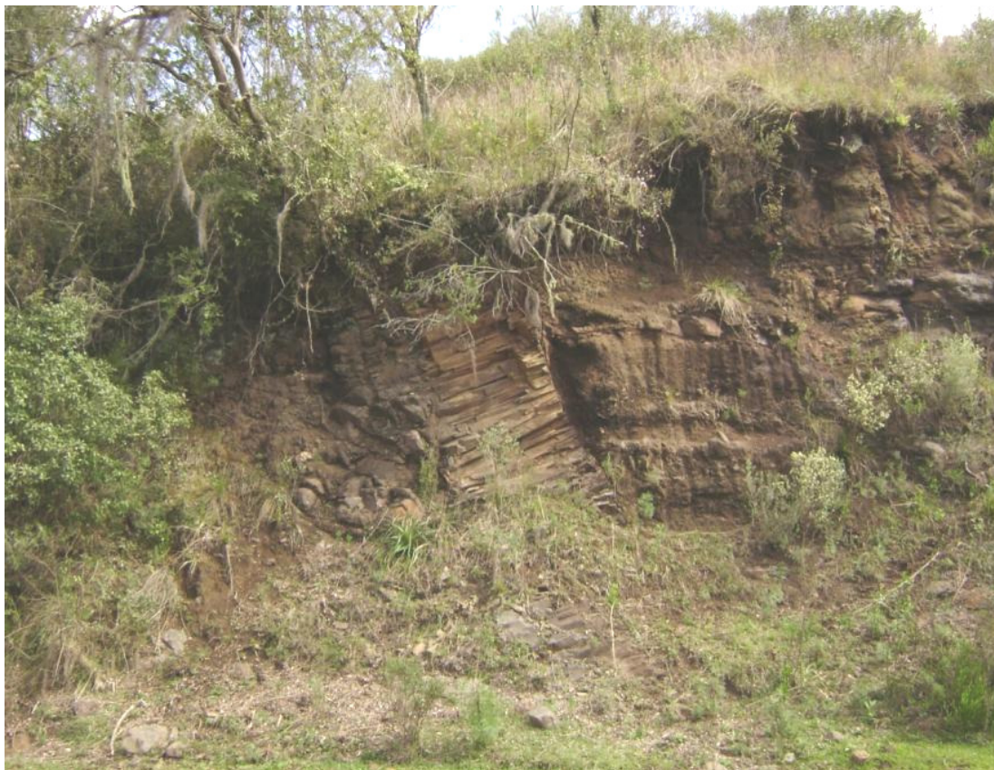
Foto 5-9 Vista de um dique de diabásio na margem esquerda do Rio Pelotas no trecho em que está previsto o AHE Passo da Cadeia – este é um dos tipos de descontinuidade que potencializa a infiltração da água no subsolo e pode comprometer a estanqueidade de um reservatório
