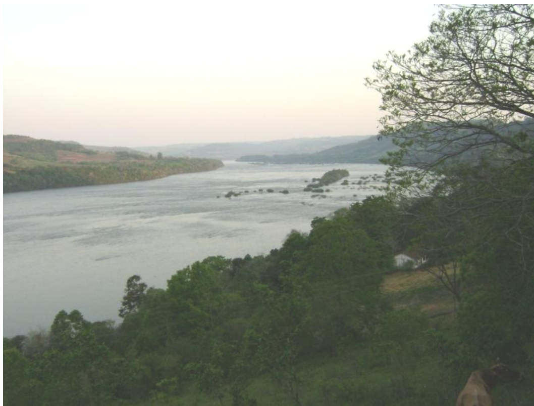
Foto 5-8 Vista geral 2 da calha do rio Uruguai no trecho do projeto da barragem Itapiranga – rio com leito rochoso, vale com profundidade média, com margens mais suaves e ocorrência de terrenos coluvionares espessos
