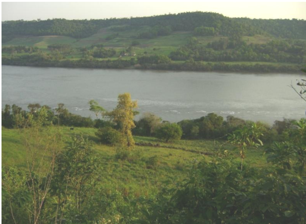
Foto 5-7 Vista geral 1 da calha do rio Uruguai no trecho do projeto da barragem Itapiranga – rio com leito rochoso, vale com profundidade média, com margens mais suaves e ocorrências de terrenos coluvionares espessos
