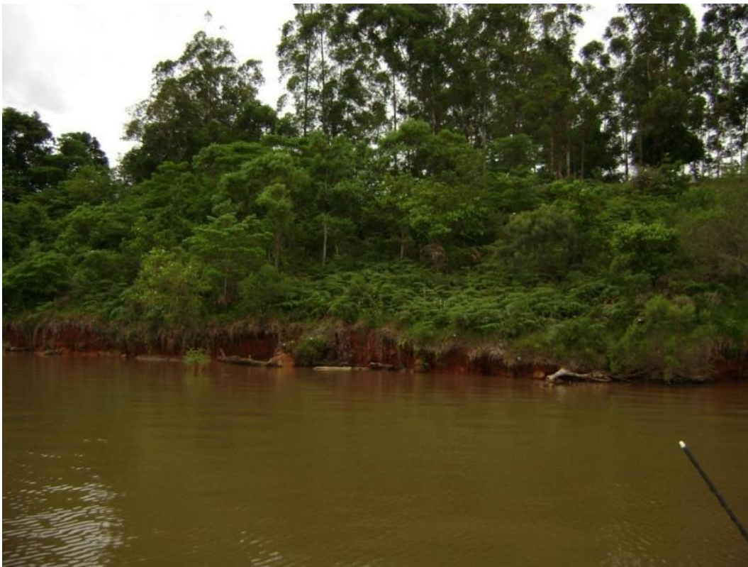
Foto 5-14 Vista geral de um talude coluvionar na margem do reservatório da Barragem de Itá – vê-se na linha d'água erosão do talude, potencializando a instabilidade do mesmo ao escorregamento
