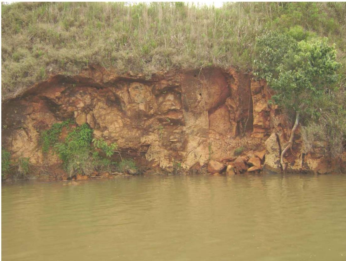
**Foto 5-15 Vista geral de um talude de rocha decomposta na margem do reservatório da Barragem de Ita, com ocorrência de um escorregamento**
