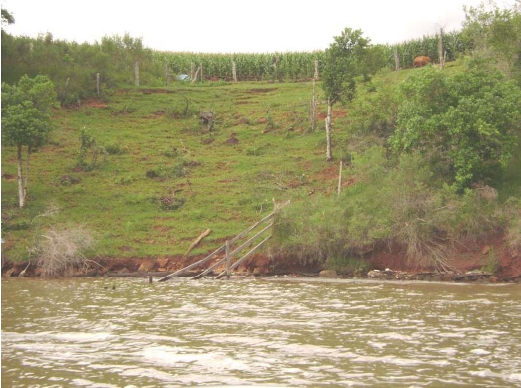
**Foto 5-13** Vista geral de um talude coluvionar na margem do reservatório da Barragem de Itá – vê-se na linha d'água erosão do talude, potencializando a instabilidade do mesmo ao escorregamento
